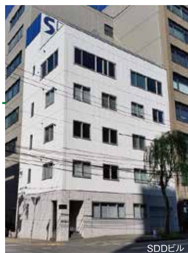
SDDビル SDD SYSTEM DESIGN DEVELOPMENT CO., LTD. システムデザイン開発株式会社
